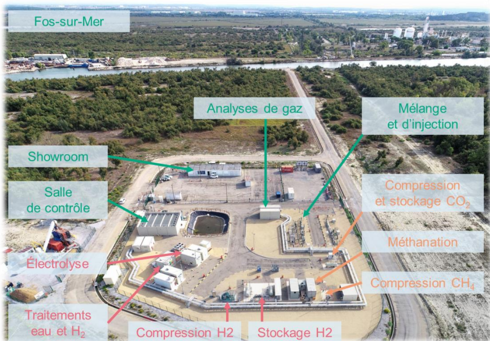
55 56 Fig. 2. Vue aérienne des installations de Jupiter 1000.
